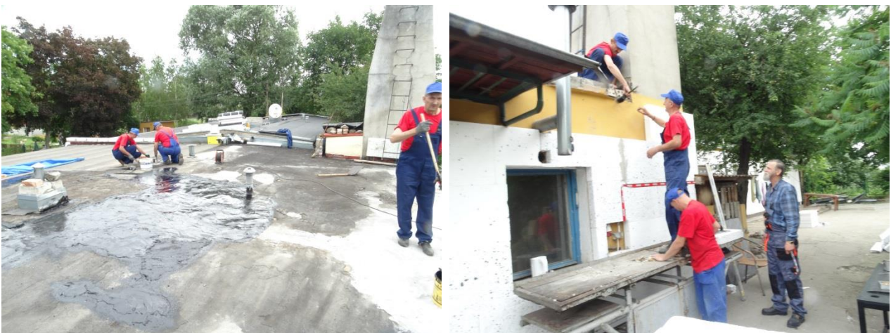
Naprawa dachu i termomodernizacja schroniska na ul. Kawiary
