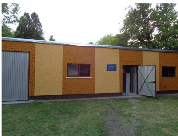
Pawilon warsztatu remontowo-usługowego
