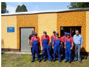
Pawilon warsztatu remontowo-usługowego
